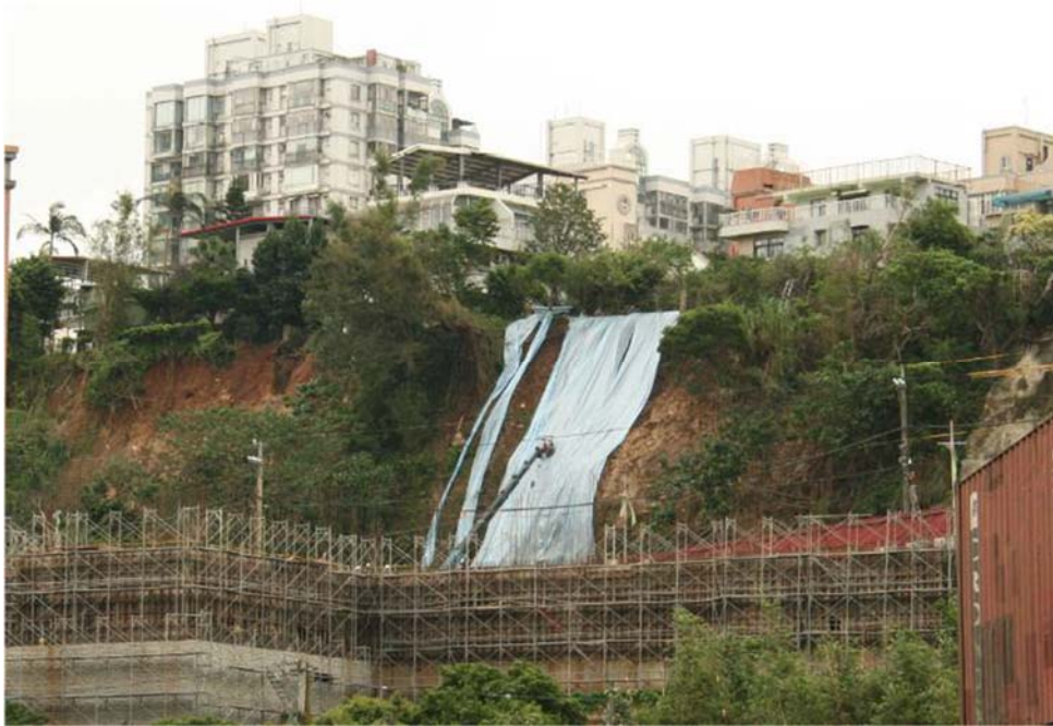
圖 4 柯羅莎颱風時淡水區崩塌情形
