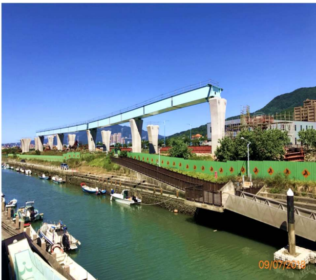
圖六 施工中淡江大橋
