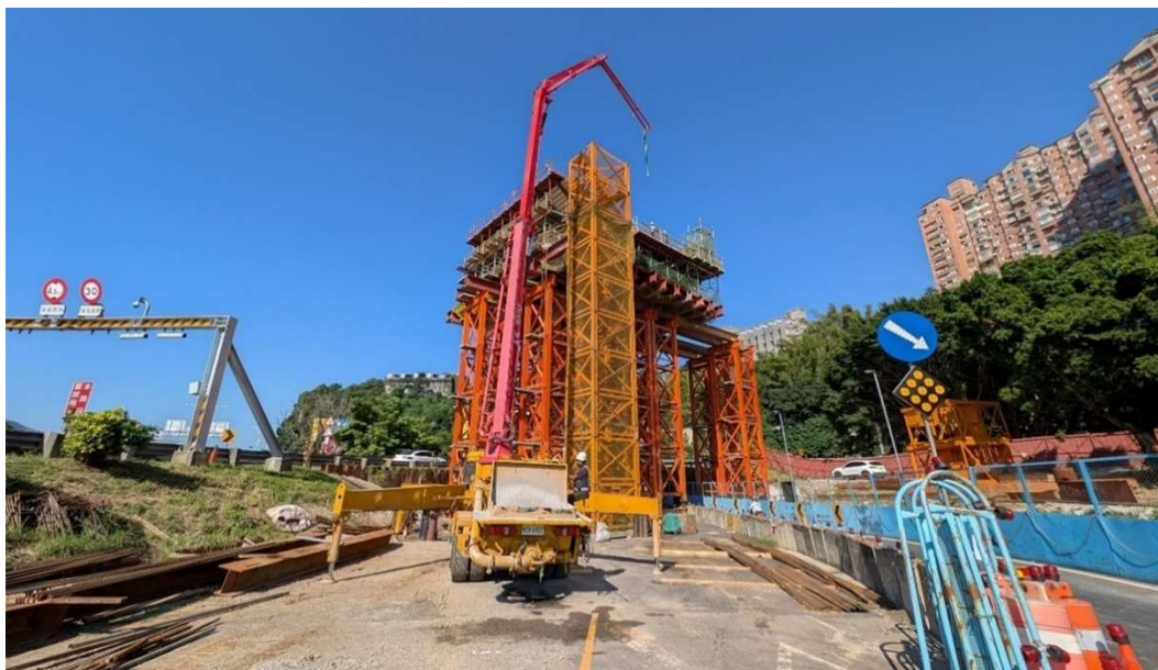
圖八 淡北道路施工圖
